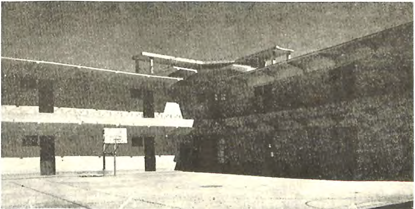
Interior de la Escuela Prevocacional de León. (1938-1939).
