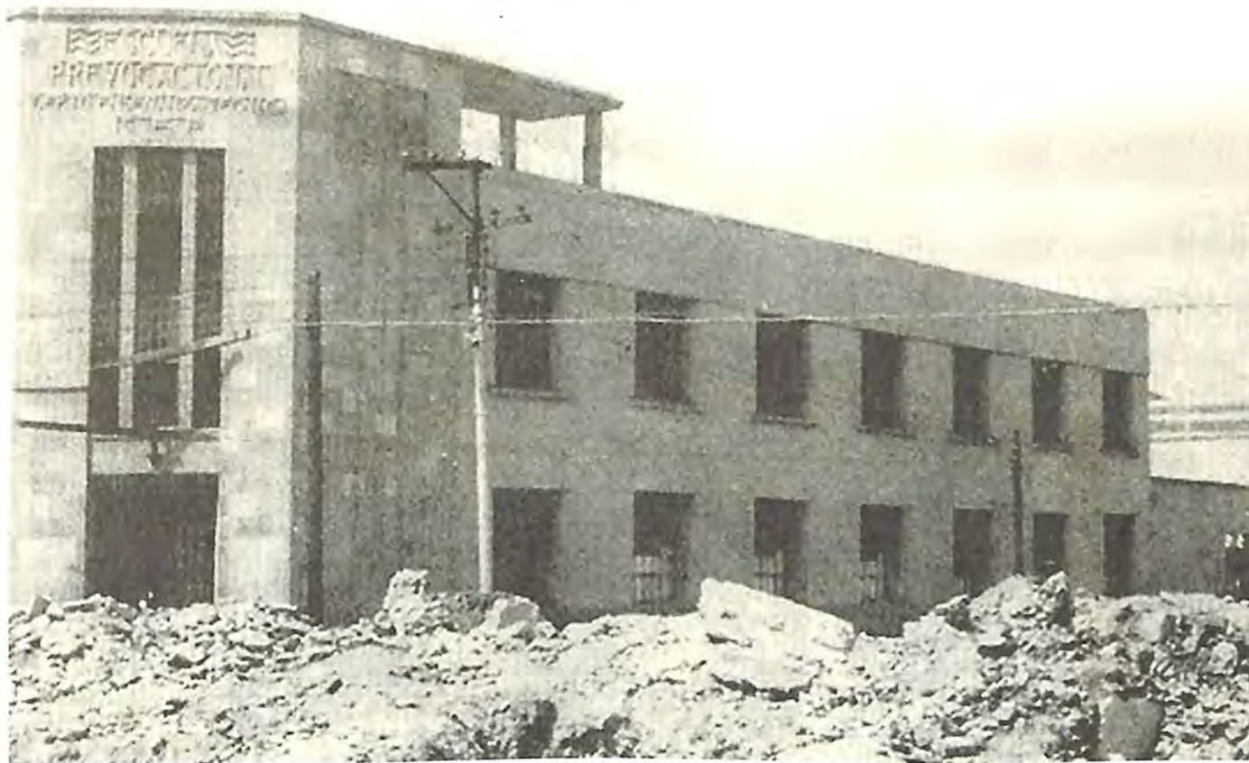
Fachada de la Prevocacional, durante las obras de construcción del Bulevar Adolfo López Mateos. (1963).
