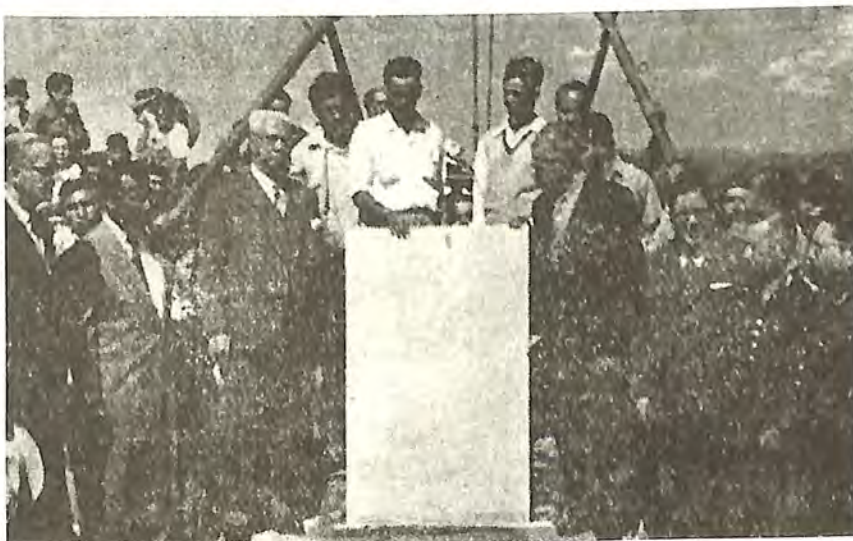
Colocación de la primera piedra de la Presa El Palote. 1953.
