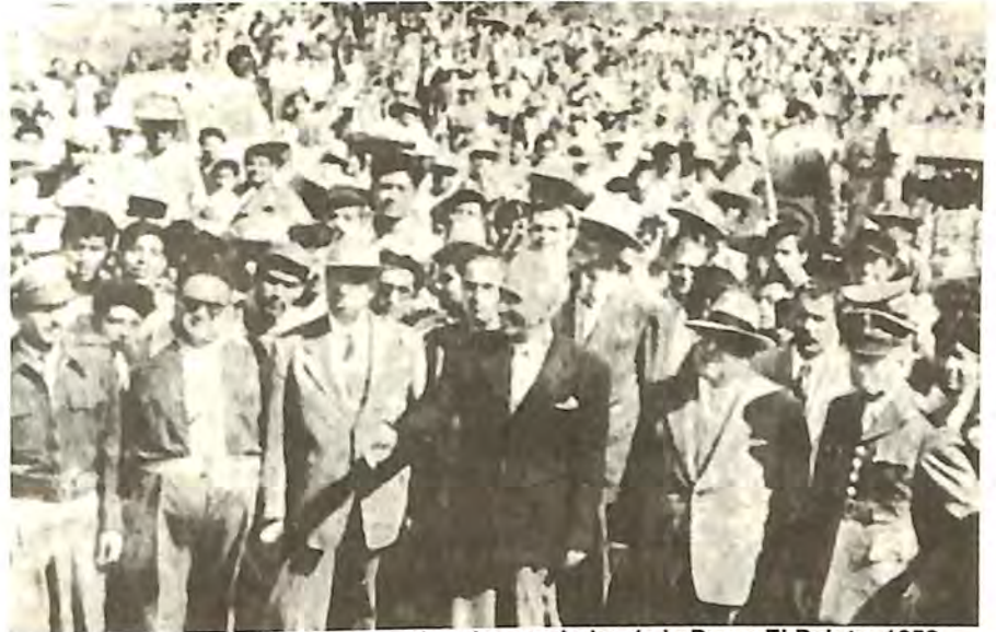
Inicio de los trabajos al colocar la primera piedra de la Presa El Palote. 1953.
